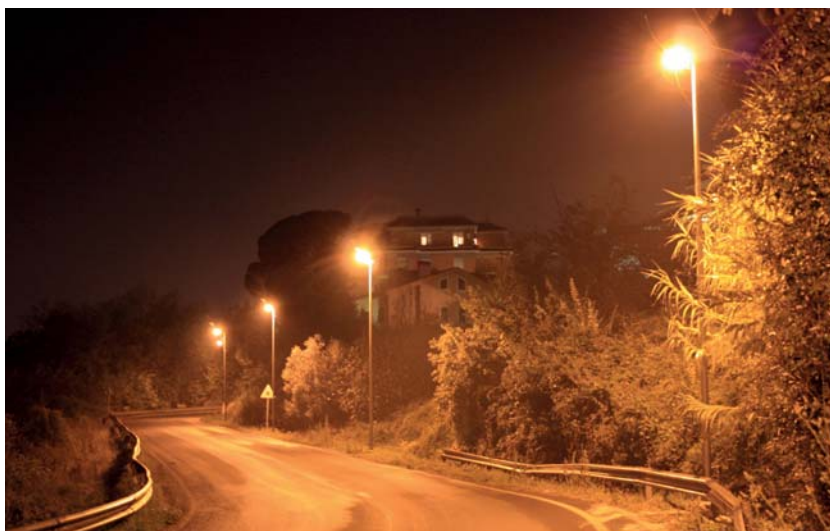
Fig 4. Lo stesso impianto con i vetri piani al posto delle coppe curve (altro tratto di strada).
