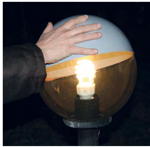
Figura 1 e 2. Foto con sfera: calotte per la schermatura di sfere da 250 e 300 mm.
